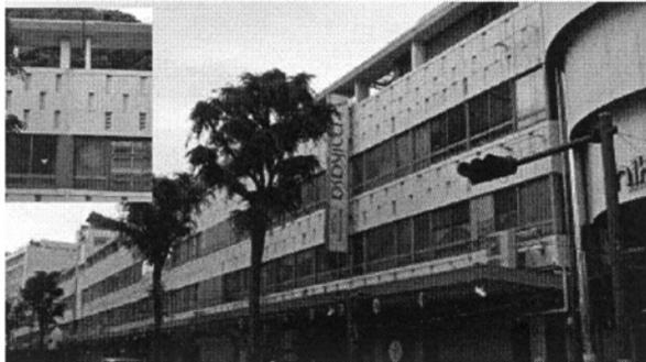
図4 三笠ビル（2018撮影）縁が切れている外壁
